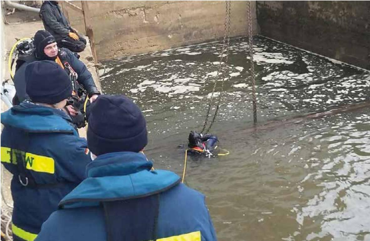
Am 17. März waren unsere **Bergungstaucher** erneut in Lauf an der Pegnitz im Einsatz. Bereits 2017 haben sie die Städtischen Werke bei Reparaturarbeiten an einer Turbine unterstützt. Hierbei musste ein Teil des Wehres trockengelegt werden, damit die Arbeiter Zugang zur Turbine bekamen. Die Aufgabe diesmal bestand darin, das Holzschott, welches zuvor installiert wurde, wieder zu entfernen.
