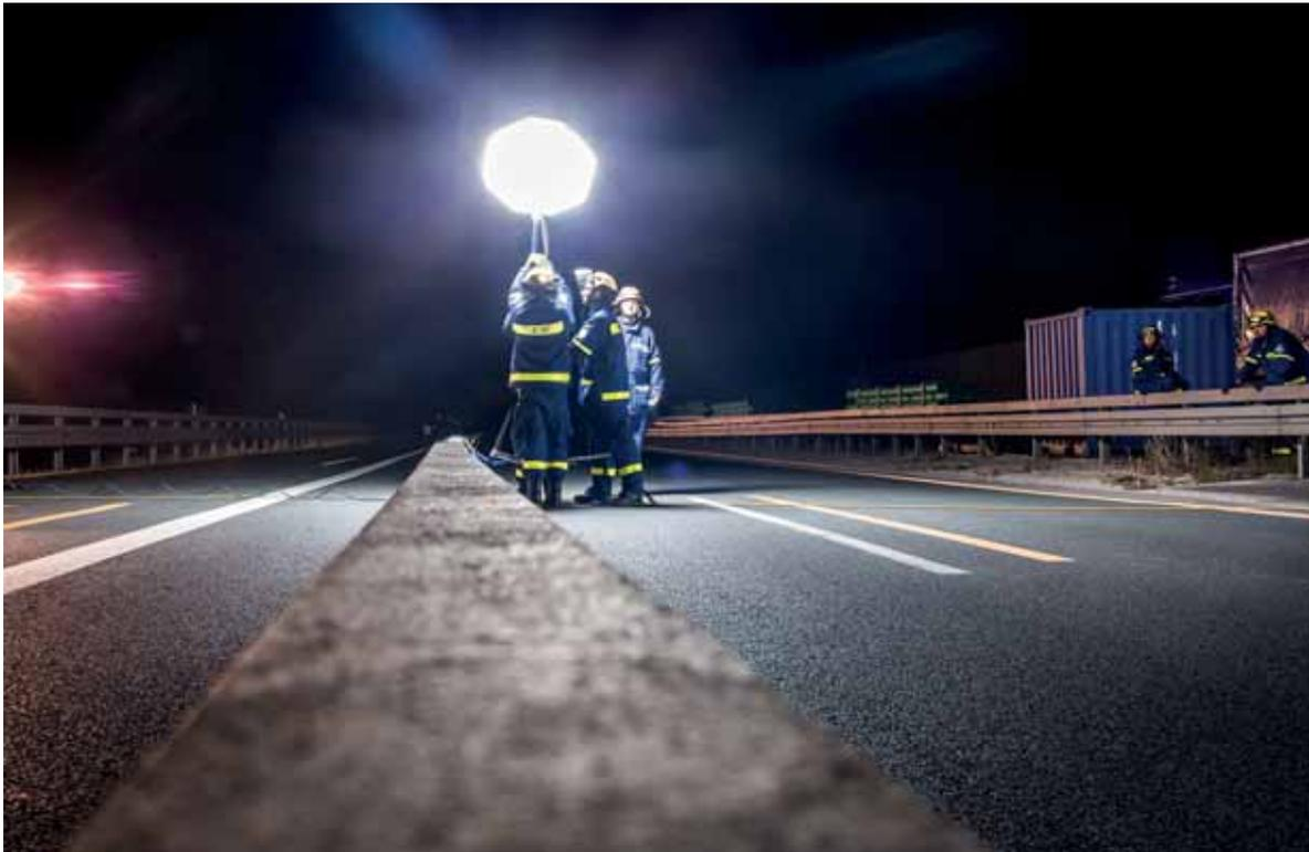
**Die Nacht zum Tag** machte das THW Forchheim im Rahmen einer technischen Hilfeleistung an der Autobahn. Die Hochspannungsleitung, welche über die A73 verläuft, musste wegen des neuen Lärmschutzwalls an neue, höhere Masten gespannt werden. Mit der Beleuchtungsausstattung sorgten die Helfer auf der Baustelle dafür, dass die nächtlichen Arbeiten gefahrlos durchgeführt werden konnten.
