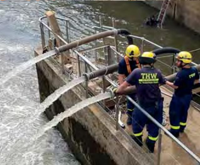
Im Juni waren die Bergungstaucher des Technischen Hilfswerks (THW) aus Forchheim in Lauf an der Pegnitz im Einsatz. Um eine defekte Turbine an einem Wehr austauschen zu können, musste ein Bereich abgeschottet und leerpumpung werden. Um diese Aufgabe bewerkstelligen zu können, sollte ein Holzschott unterhalb des Wehres angebracht werden. Dazu rief man die Bergungstaucher des THW zu Hilfe.
