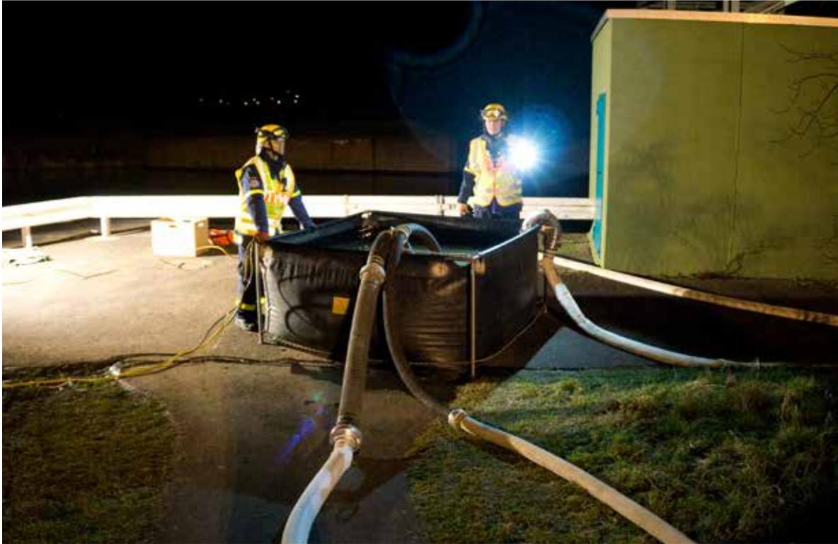
Einen Höhenunterschied galt es für die **Fachgruppe Wasserschaden/Pumpen** mittels Tauchpumpen bei einer Ausbildungsveranstaltung im März zu überwinden. Hierzu installierten die Fachhelfer der WP eine Pumpstrecke auf dem Betriebsgelände des Wasserwirtschaftsamtes in Neuses. Die Strecke verlief vom Main-Donau-Kanal über eine Brücke und in Höhe der Schleuse wieder in den Kanal. Dabei kamen verschiedenste Tauchpumpen zum Einsatz.
