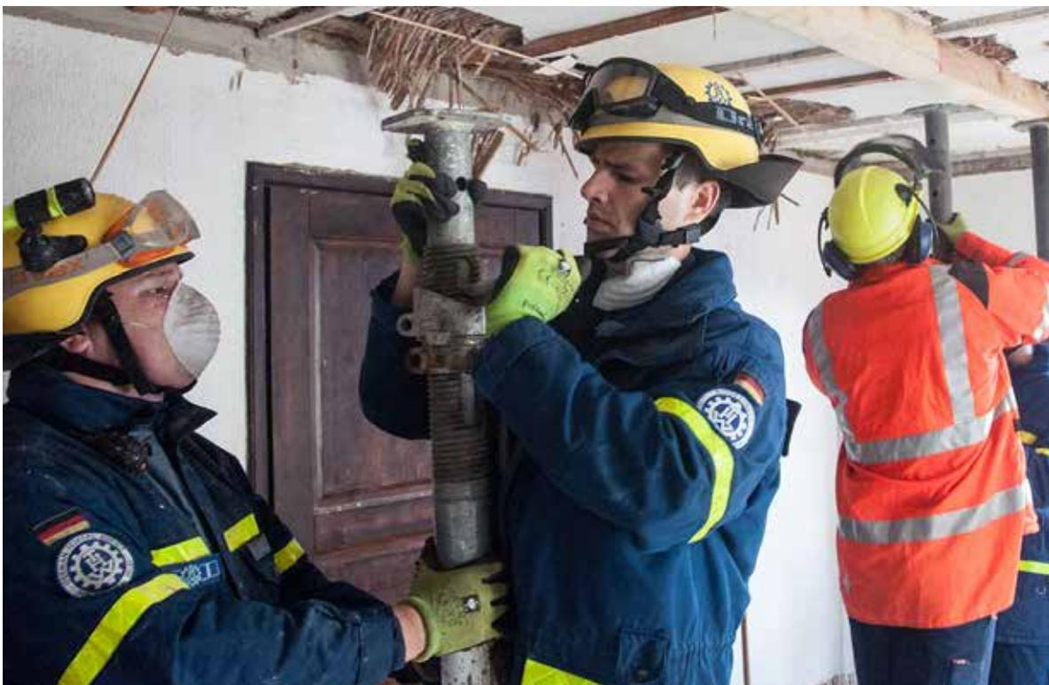
Für Abstützmaßnahmen zur **Sicherung eines Wohnhauses** war das THW im August in Heßdorf im Einsatz. Durch einen massiven Wasserschaden war die Bausubstanz dermaßen stark in Mitleidenschaft gezogen, dass Einsturzgefahr bestand. Gemeinsam mit dem THW Baiersdorf konnte das Gebäude mittels Schwelljochen abgestützt werden. Der Baufachberater des THW Forchheim war ebenfalls mit im Einsatz.
