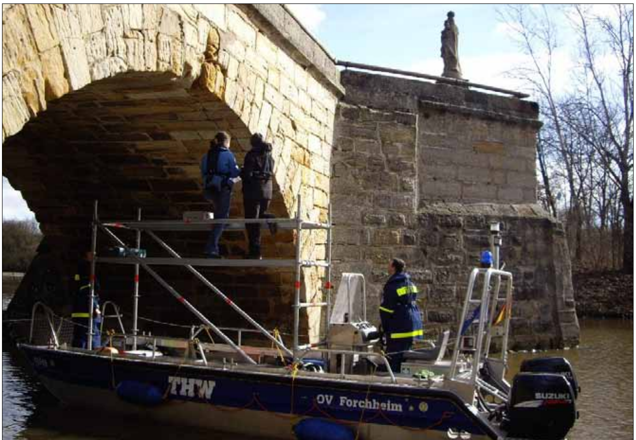
Für eine Amtshilfe historischer Art war das THW für die Stadt Forchheim im Februar im Einsatz. Für die Untersuchung der Alten Regnitzbrücke musste eine schwimmende Arbeitsplattform bereitgestellt werden. Mit dem Mehrzweckarbeitsboot und dem Einsatzgerüstsystem (EGS) war die Umsetzung kein Problem. Foto: Patrick Hoch
