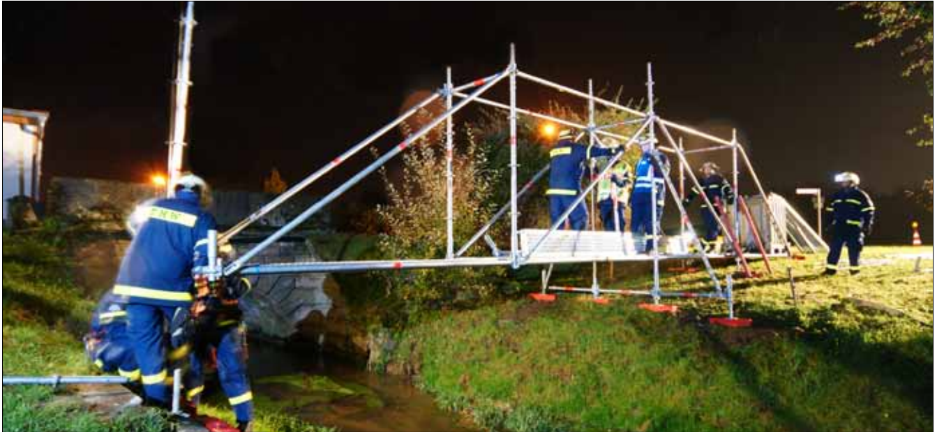
Einen Behelfssteg musste die 2. Bergungsgruppe mittels Einsatzgerüstsystem bauen. Foto: M. Holler
