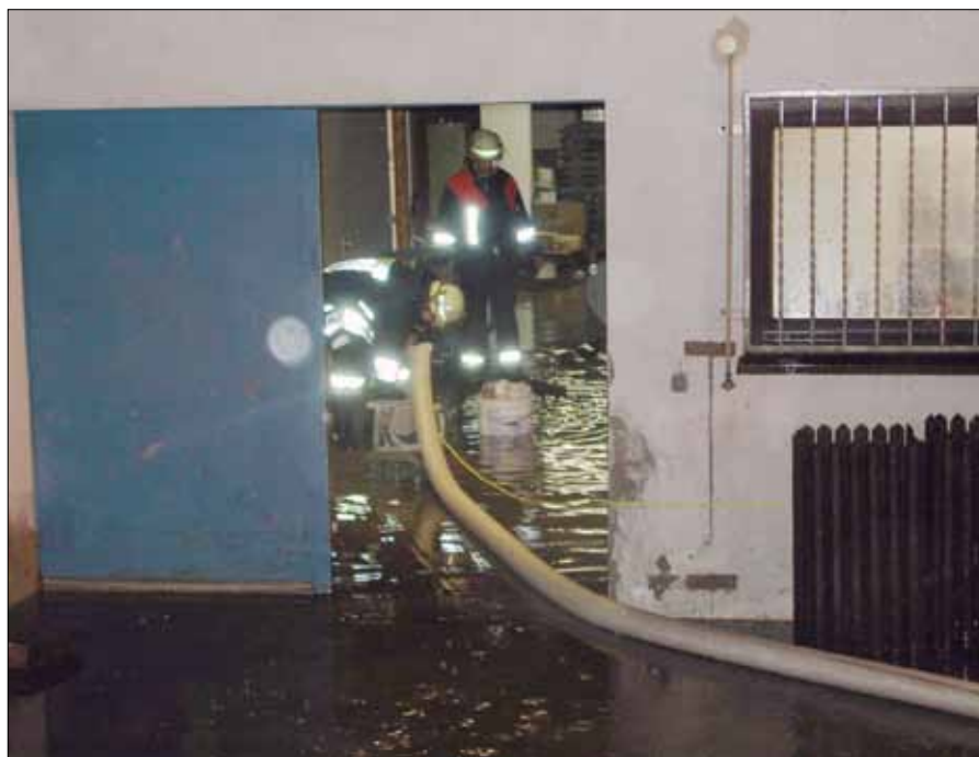
Selbst das Feuerwehrhaus stand unter Wasser. Fotos: Thomas Wilfling
